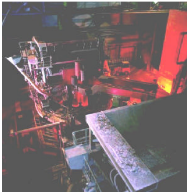
Foto 1: HORNO DE ARCO ELÉCTRICO Y CUBA PARA CARGA DE CHATARRA
